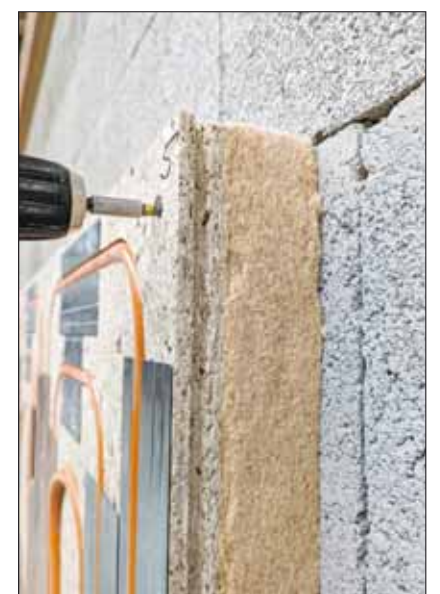
Abbildung 13 Befestigung des Elements an der Bestandswand mittels Schraubverbindung – sehr gute Anpassung der flexiblen Dämmung an die Wand
