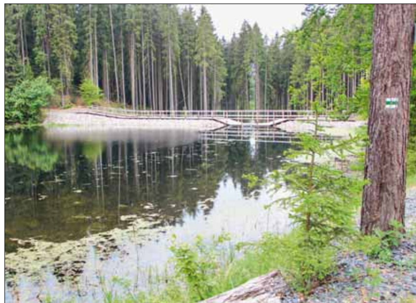
Neben der Neuanlage wurde auch in die Sanierung von Lösschteichen im Wald investiert, wie hier im Forstamt Neustadt/Orla mit befahrbarem Damm und Überlauf. Foto: Horst Sproßmann/Thüringen-Forst
